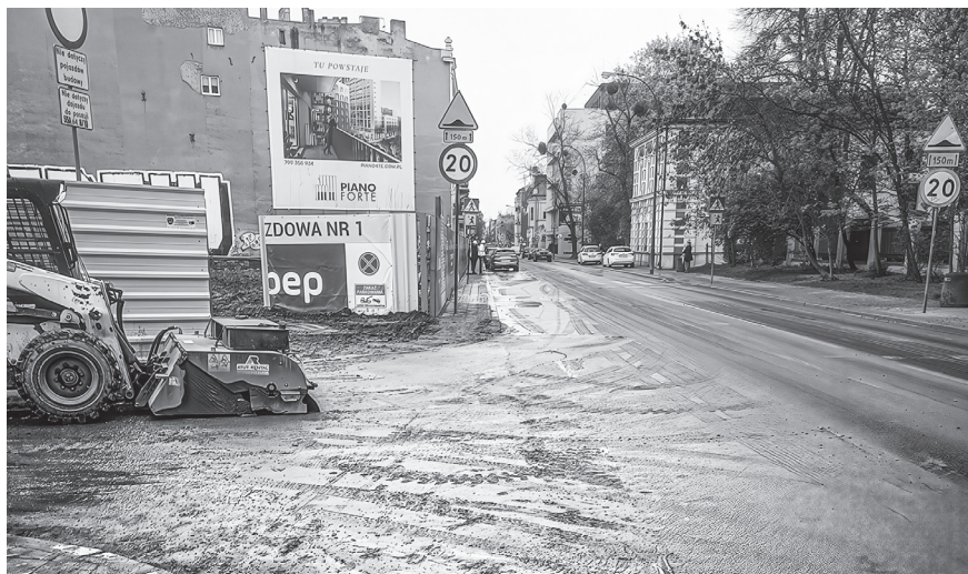
Błoto wywiezione na kołach ciężarówek wyjeżdżających z placu budowy, ulica Jaracza Fot. Martyna Urbańczyk
